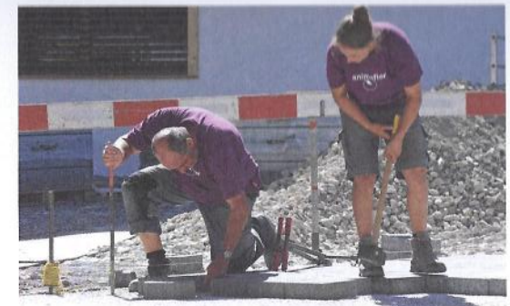
Das Verlegen grosser Flächen geschieht weitgehend maschinell und dadurch sehr schnell.
